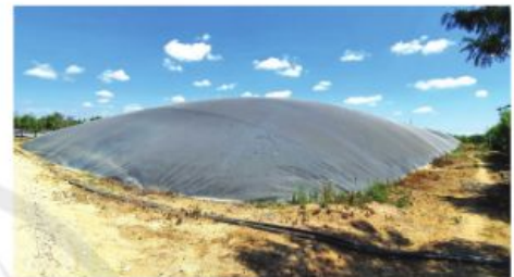
Hình 13.1. Hầm biogas xử lý chất thải tại một mô hình chăn nuôi ở Cư Jút, Đắk Nông
